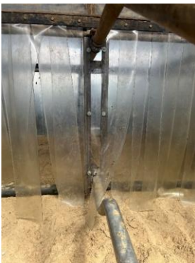
Billede 1 Her ses opbygning af metanhusene med hhv. plastlameller, jernramme og plader af transparent polycarbonat.
