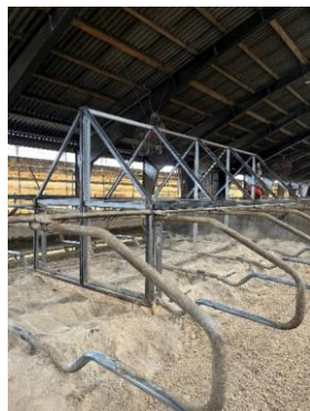
Billede 1 Her ses opbygning af metanhusene med hhv. plastlameller, jernramme og plader af transparent polycarbonat.
