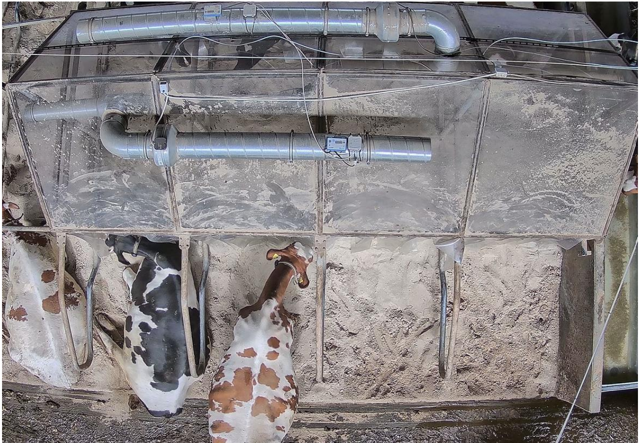
Billede 2 Her ses metanhuset i den dobbelte sengebåserække kort tid efter at det hele stod færdigt.
