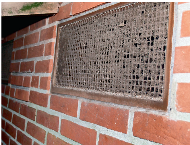
Beskidte vægventiler giver et reduceret luftindtag.
