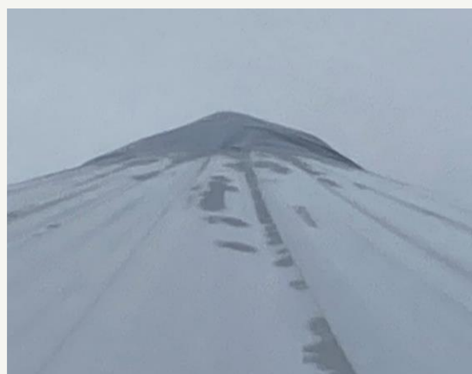
Billede af eftermonteret, på svejst dug for at lukke for uønsket metan diffusion igennem udluftningshuller.
